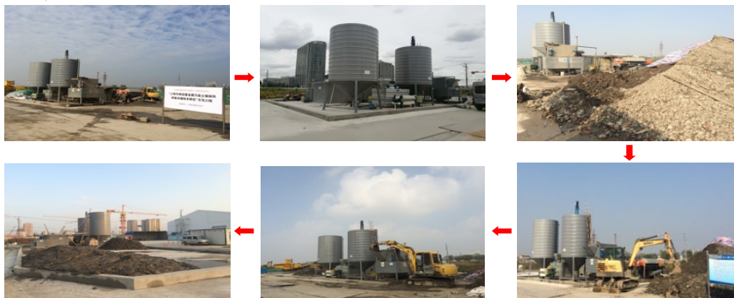
图 2 淋洗修复过程现场图
